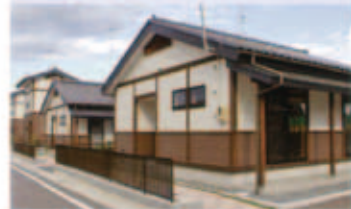
手前が平屋、奥が2階建ての住宅。1軒ごとに駐車スペースもあります。
