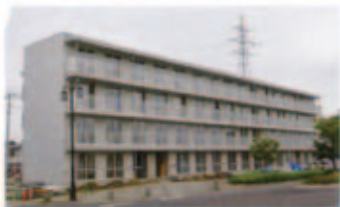
建設中の双葉町民向け復興公営住宅（郡山市/山田）
