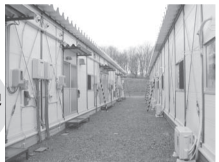
临时住房外观 (新地町)
